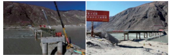
图 9 竹巴笼大桥被冲毁前与抢修后
