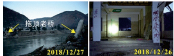
图 11 拖顶老桥与五境乡受损房屋
